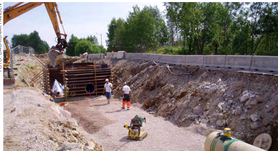
Byggingen av RGA. Store dimensjoner krever store anlegg.
