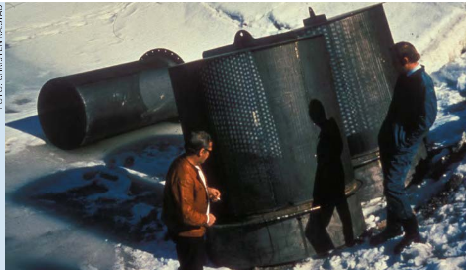
Dette er inntakssilene som nå er montert på 30 meters dyp i Glitre.
