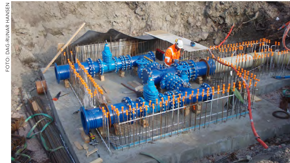
Byggingen av ilandføringskummen til sjøledningen til RDS på Strømsø.
