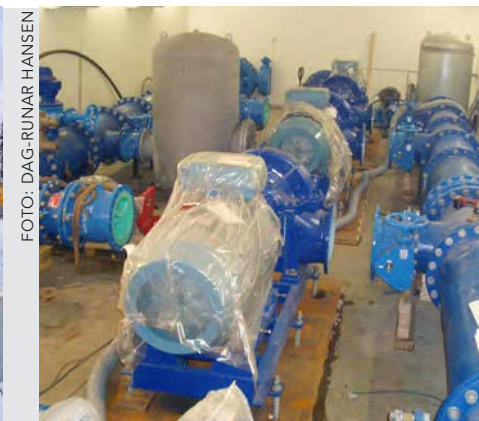
Nye deler har ankommet Stokke pumpestasjon, som er en del av RGA-prosjektet.
