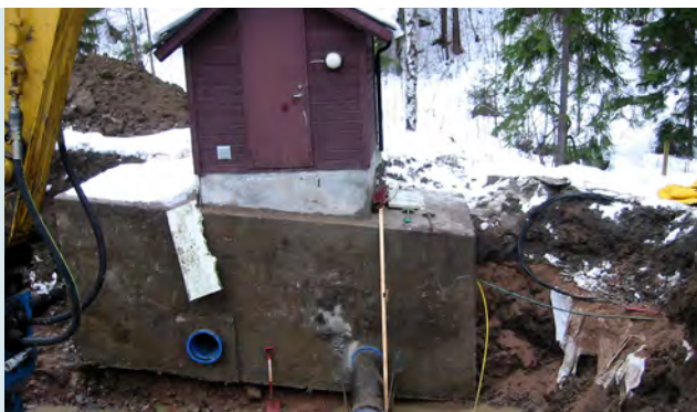
Klorkummen ved Sætervann rett før ombyggingen i 2003.
