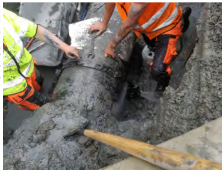
Anboringsklamme settes på en lekkasje.
