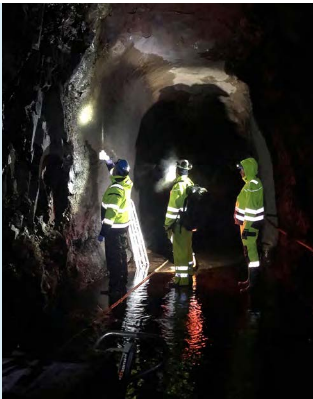
Våren 2018 ble det foretatt en grundig inspeksjon av Kloptjern fjellbasseng. Fjellkvalitet, fiberkabel og mulig innlekking ble sjekket.
