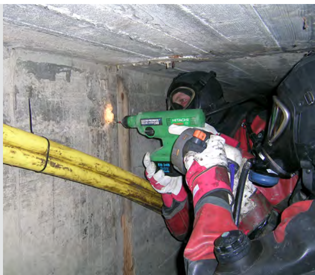
Montering av trekkerør for fiberkabel i bekkelukking på Brakerøya.
