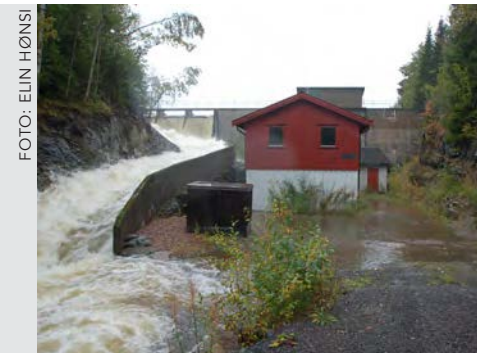
Uværet Petra 2015 førte til flom ved Bremsa. Vannbehandlingsanlegget for reservevannforsyning ble ikke skadet.
