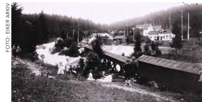
Rørledningen til Krokstad Cellulose i Krokstad-bekken og Den Norske Galoge- og Gummivarefabrikk ("Kalosjen").
