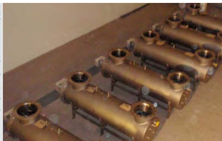
UV-anlegg installeres på Landfall vannbehandlingsanlegg i 2011.
