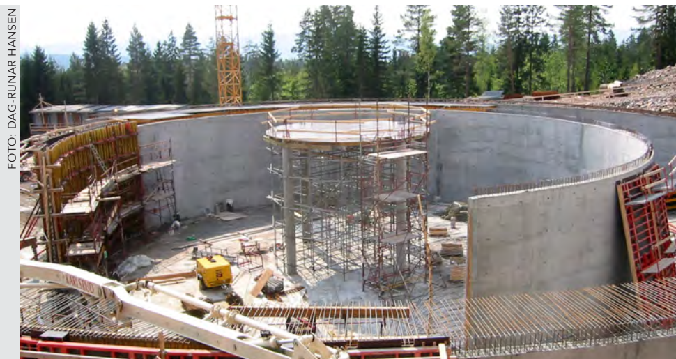
Høydebasseng bidrar til å sikre vannforsyningen både gjennom å jevne ut vannproduksjonen og gjennom å være reserve. Bildet er tatt under oppføringen av Gullaug høydebasseng.
