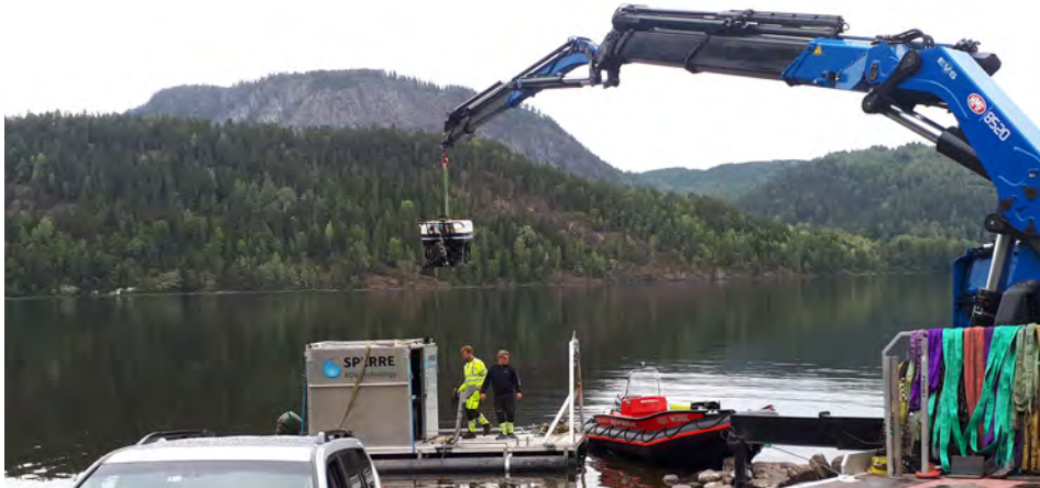
Miniubåt senkes ned i Holsfjorden for å spyle og rense inntakssilen til Sylling vannbehandlingsanlegg.
