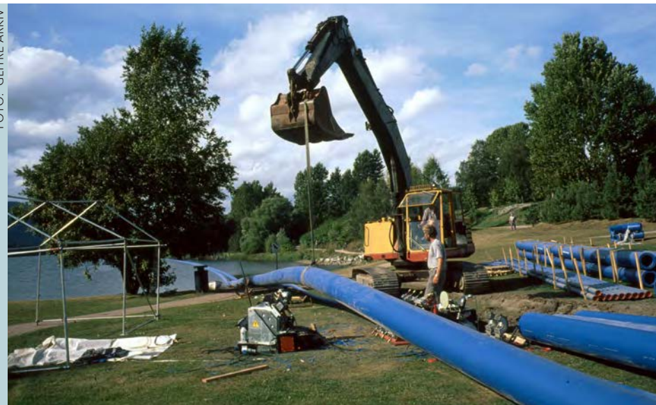
Her legges de to 280 mm vannledningene under elven fra Åssiden til Gulsbogen i 1999. Disse gjorde at Bremsa vannverk kunne fases helt ut.
