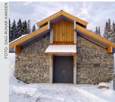
Gullaug høydebasseng er bygget for å passe inn i terrenget og stå i mange år.
