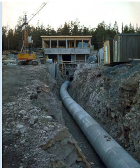
Landfall vannbehandlingsanlegg under bygging.
