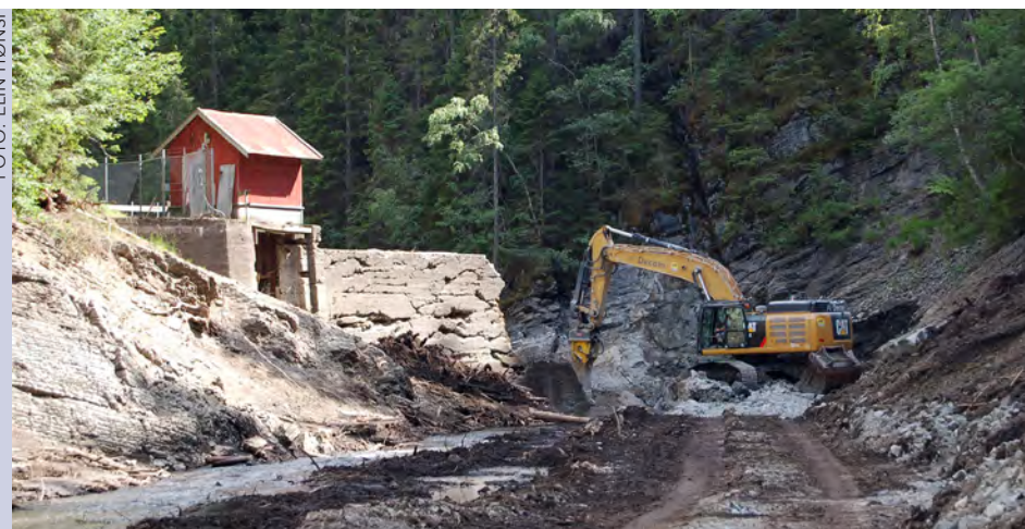
Høgfossdammen inngikk i A/S Børresens kraftproduksjon som ble nedlagt ved en overenskomst med Glitrevannverket. Dammen ble revet i 2014.
