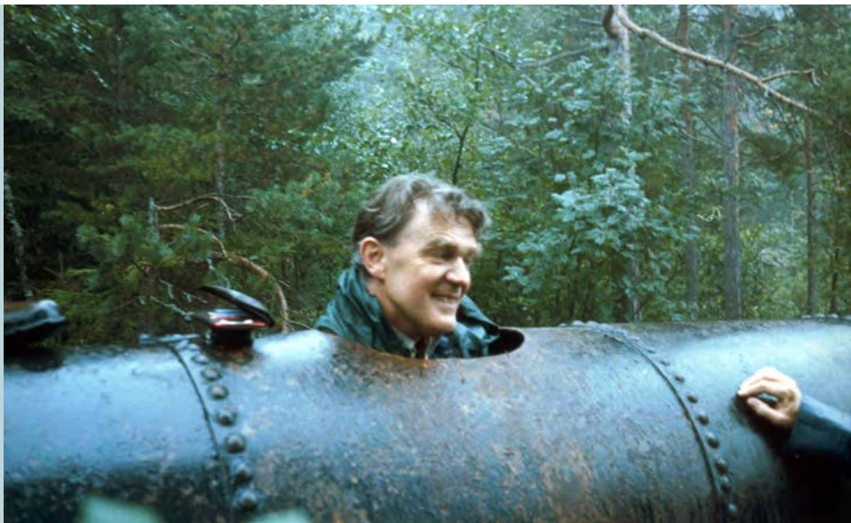
Rolf Haugerud stikker hodet opp av vannrøret (tidligere turbinrør) fra Vasshella ned mot bygda.
